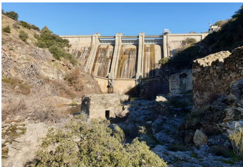
Presa de Picadas
