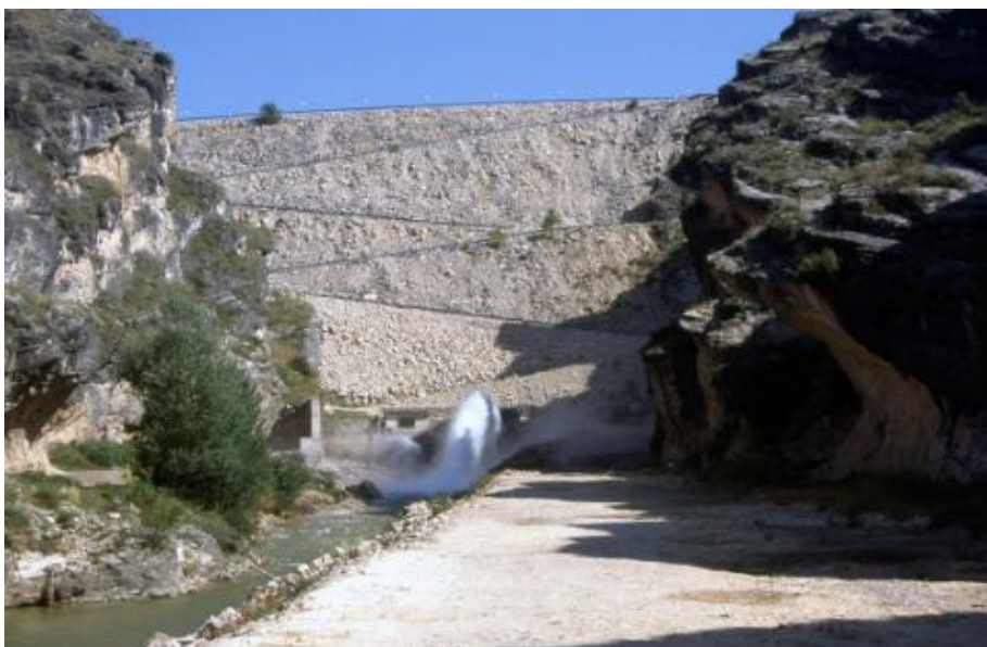
Presa de Alcorlo
