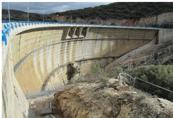
Presa de La Tajera
