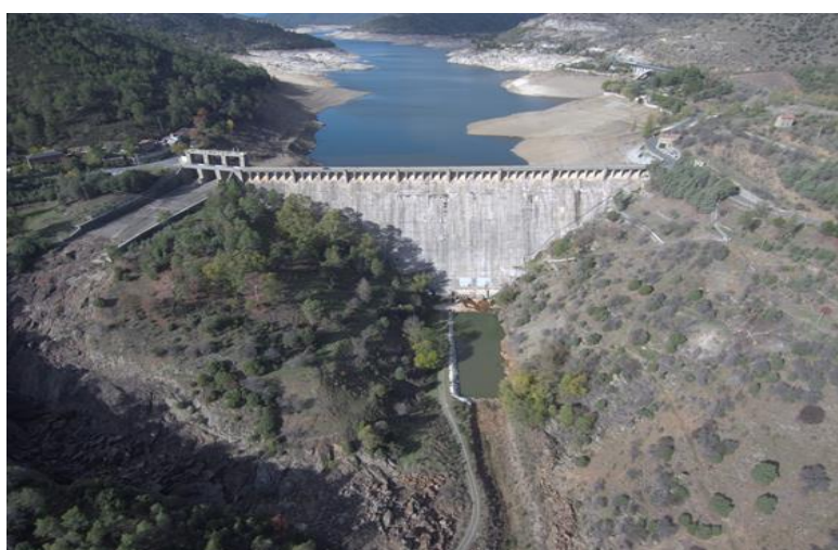
Presa de Burguillo
