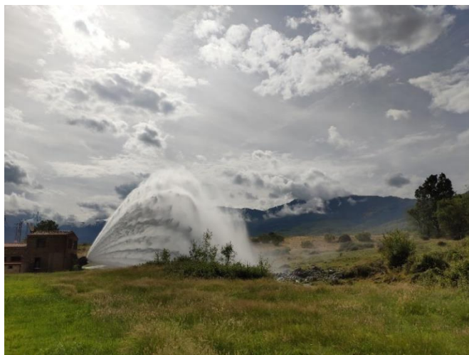
Presa de Baños – Desagües de fondo
